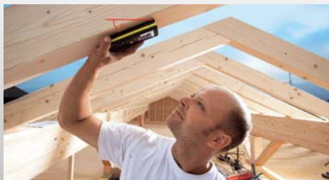
Zimmermann – Neigungsmessung über Kopf mit dem 360° Neigungssensor
